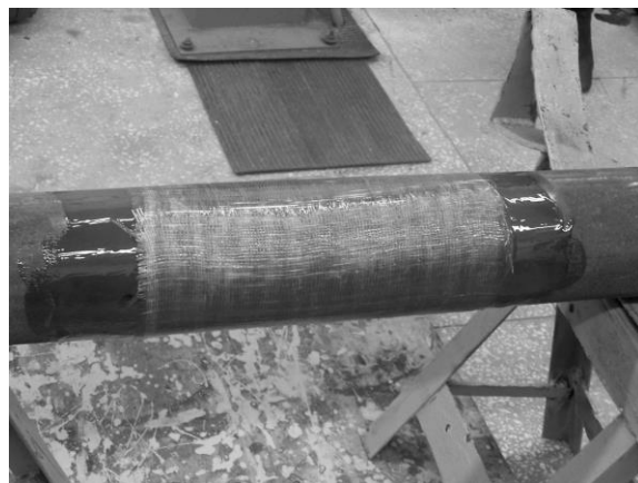
рис. 11 Обертывание трубы стеклотканью
