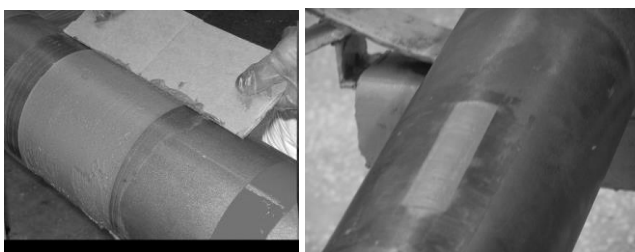
рис. 5. Используйте прямоугольную пластину для выравнивания
