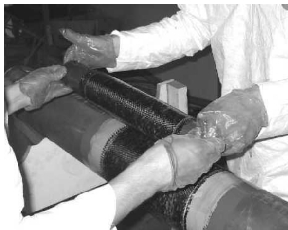
рис. 12 Использование ленты с трубки
