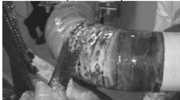
рис. 15. Оборачивание колена
