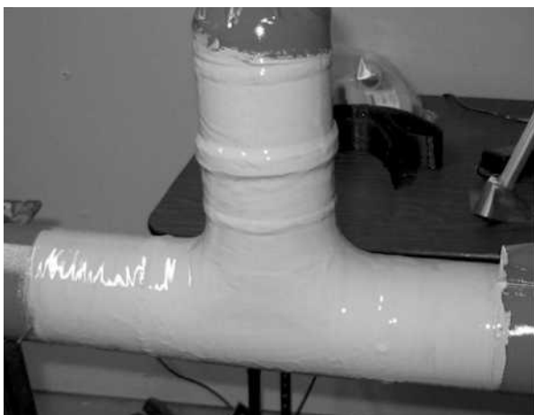
рис.17. Подготовка тройника грунтовочным средством
