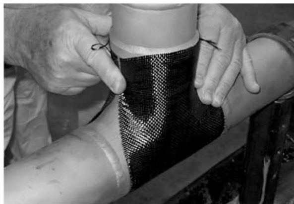
рис. 16. Оберните углеродную ткань на сухую чтобы проверить совмещение
