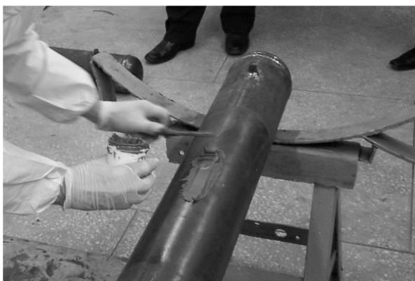
рис.4. Заполните пустоты шпатлевкой
