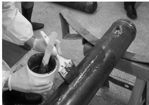
рис. 7. Нанесите грунтовочный состав на трубу
